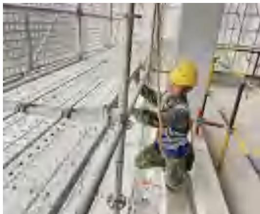
2.1.13 外脚手架搭设至作业层时,脚手架外排立杆悬臂高度不宜大于3m,搭设可靠稳定,且防护栏杆可承受任何方向最小 $1.0\text{kN}/\text{m}^2$ 外力作用。
