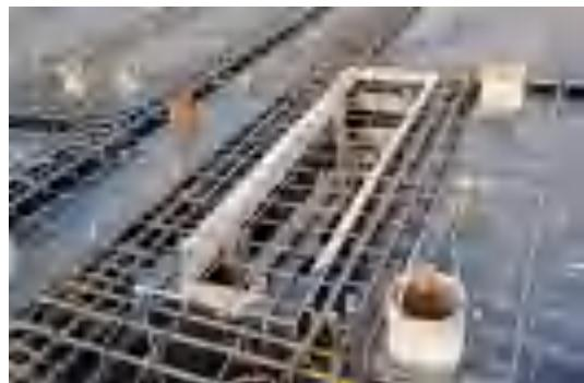
2.1.16 施工作业层电梯井宜根据电梯井大小制作集成式钢网片，临时固定于电梯井处进行防护。
