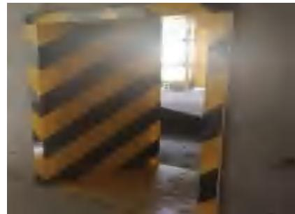
2.2.7 排烟道、排气道、水井、电井、传料洞口等预留洞口短边边长为 25mm-500mm 时,应设置满足承载力的盖板覆盖;短边边长为 500mm-1500mm 时,应采用盖板覆盖或防护栏杆等措施;短边边长大于或等于 1500mm 时,应在洞口作业侧设置高度不小于 1200mm 的防护栏杆,洞口应采用安全平网封闭。洞口防护应紧随作业层,盖板宜刷黑黄色(白红)警示油漆。
