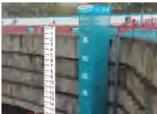
2.6.2 桩井开挖深度超过两米时,桩(井)口四周必须设置临边防护,采用人工挖孔时,孔内必须设置应急软爬梯供人员上下,作业完成后孔口应采用钢筋网片或硬质封闭进行防护。
