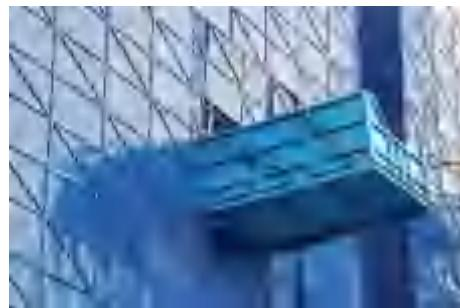
2.2.12 附着式升降脚手架或悬挑式脚手架架体与卸料钢平台交接时,交接部位应设置立
