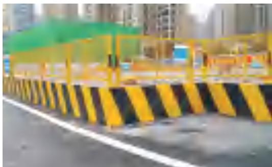
3.3.2 暗挖隧道洞口边、仰坡上方应设置防护栏杆，防护栏杆离开挖线距离不小于1m，并挂设安全警示标识、标牌。
