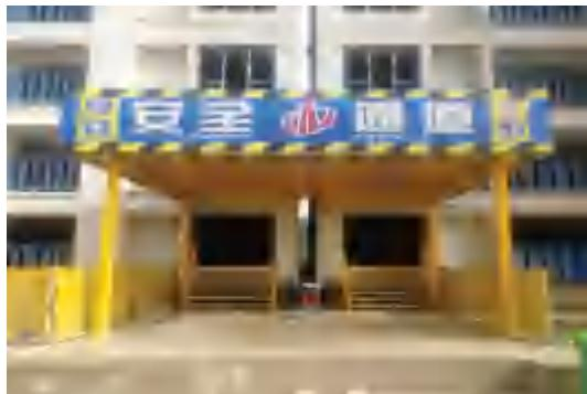
2.4.2 施工现场按楼层高度、物体坠落半径采用定型化网片或防护栏杆设置有效的防坠隔离区。
