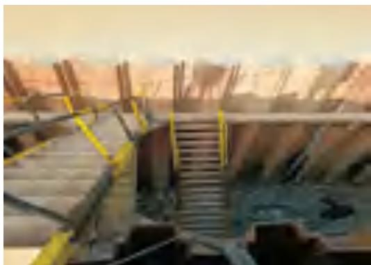
3.2.4 墩柱钢筋绑扎、模板搭设时,防护架基础应水平、坚实、平整,防护架内侧与模板间应满铺安全兜网,外侧铁丝网应满设;脚手架上应张挂“当心坠落”、“高处作业系好安全带”等警示牌。
