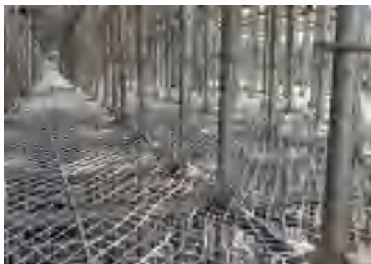
2.1.6 架体搭设及模板安装时作业面应铺设脚手板,不得有空隙或探头板,上下架体时应配备登高用具并搭设专用登高通道。
