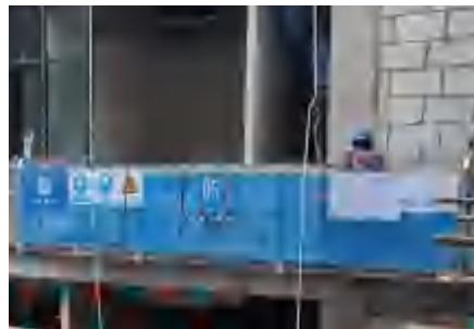
2.5.6 吊篮停用时应停靠在稳定的地面,操作人员应从地面进入吊篮,严禁在建筑物顶部、窗口等处或其他孔洞处出入吊篮,杜绝违规翻越吊篮行为。
