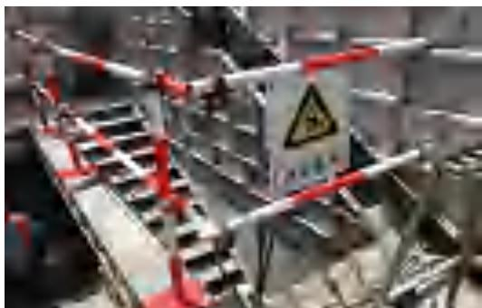
2.1.10 不同楼栋或同一楼栋不同单元间施工缝临边相差 2m 以上需设置临边防护,临边防护设置应符合规范要求。
