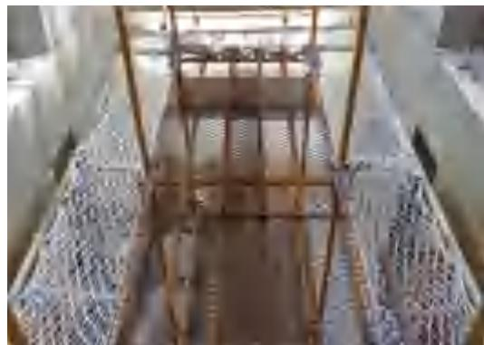
2.2.11 卸料平台在使用过程中应将两侧及前方防护到位,底部与周边应与主体结构严密封闭,附着式升降脚手架卸料平台与悬挑卸料平台四周宜设置防砸设施。
