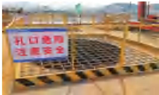
3.2.2 桩基成孔检测时,孔口上需铺设跳板,并固定牢靠。
