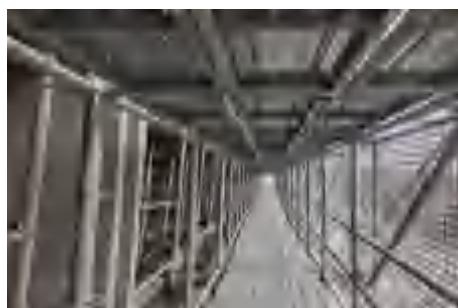
大于  $150\text{mm}$  时,应采用脚手板或安全平网进行封闭防护。
