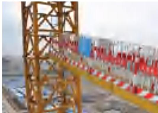
2.7.2 塔吊按照要求设置防攀爬措施,防止闲杂人员攀爬塔吊。
