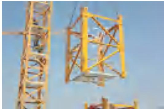
2.7.4 塔吊附墙安装操作平台采用定型化设施,平台底部与侧边防护到位,满足规范要求。
